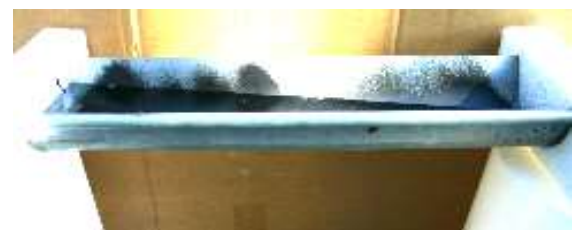
Après séchage : Les fuites sont obturées
